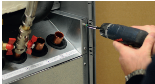
3. Avlägsna kylmodulens fästskruvar.
